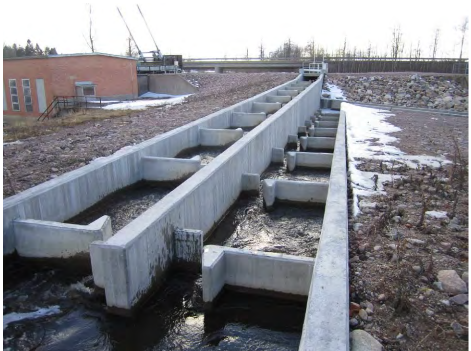
Figur 12. Exempel på teknisk fiskväg i form av en s.k. slitsränna från Kallstena kraftverk vid Hedströmmen.
