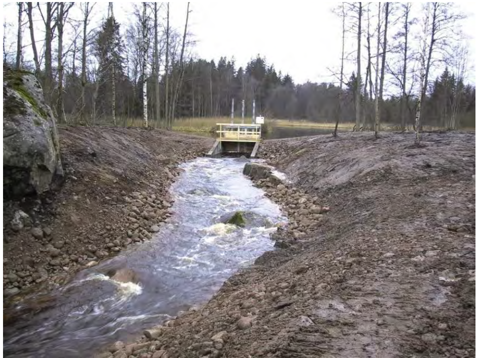
Figur 11. Exempel på en nyanlagd naturliknande fiskväg, s.k. omlöp, från Finsjö övre kraftverk vid Emån.
