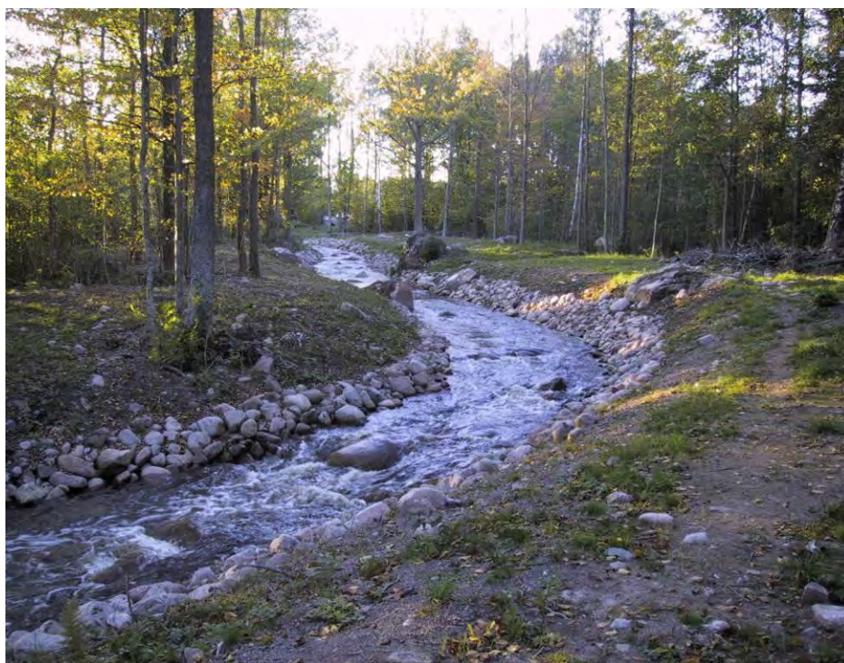
Figur 16. Exempel på ett grävt omlöp med lutning ca 2 % med tappning av ett vattenflöde på ca 1,5 m 3 /s från Skälleryds kraftverk, Alsterån.
